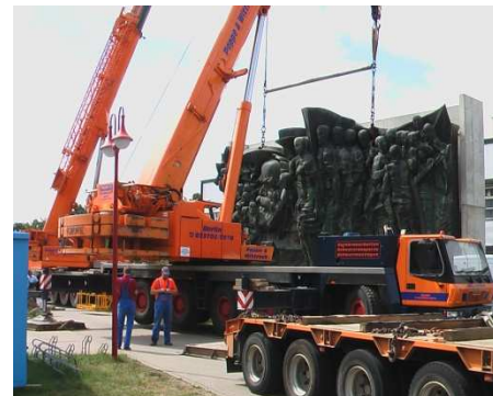
Montage mit 2 Autodrehkränen
