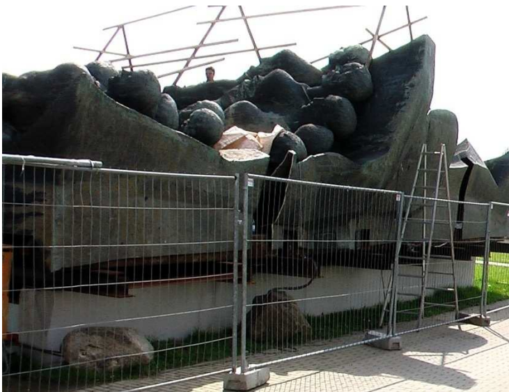
Montageplatz vor Ort
