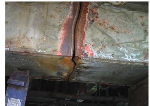
Zusammengefügte Teile und Detail einer vorbereiteten Schweißnaht
